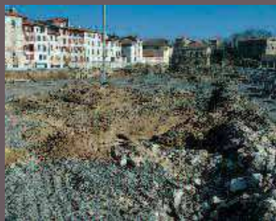
Travaux le long de la rue Pelletier
